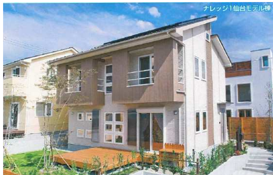
H25年度国土交通省住宅ゼロ・エネルギー化推進事業採択住宅「ナレッジ」 仙台モデル棟
